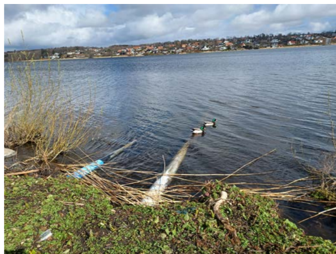
EKSISTERENDE RØR NORD FOR DE SYDLIGE TAGRØR. I DAG ANLAGT MED SYNLIGHED FRA BRINKEN.
