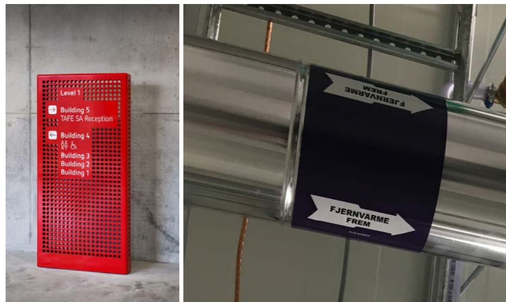
EKSEMPLER PÅ FORMIDLING PÅ 'STÅLPLANCHE' OG TRYK PÅ RØR.
